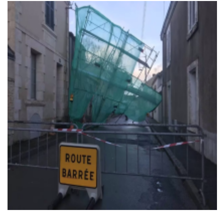
Échafaudage arraché à Fontenay-le-Comte (85)
